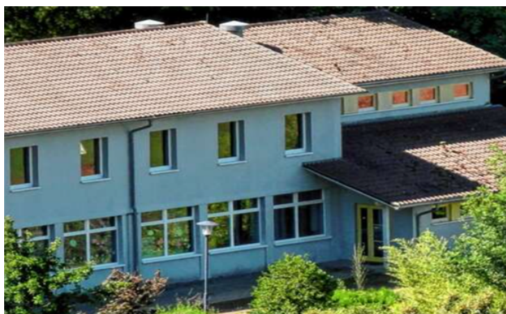
Toiture en pente
