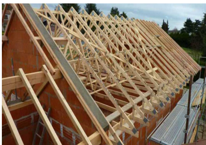
Charpente en bois
